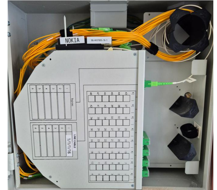
Razvodni orman ftth (FCP)
